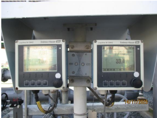
รูปที่ 3-27 ระบบตรวจสอบคุณภาพน้ำแบบต่อเนื่อง (Online Monitoring) ที่บ่อบำบัดน้ำทิ้งจากหอหล่อเย็น (CT Blow Down Pit)
