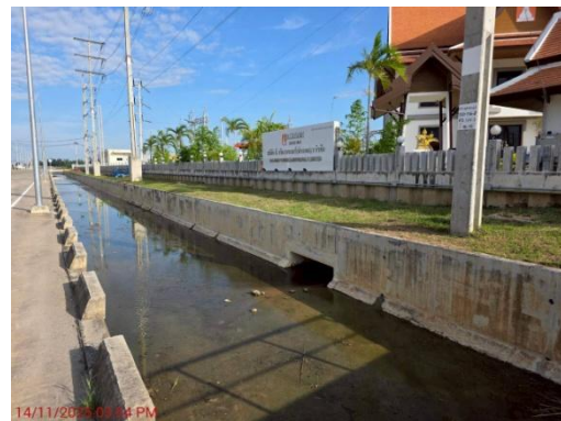
รูปที่ 3-30 รางระบายน้ำฝนของนิคมอุตสาหกรรม เอส อ่าวทอง
