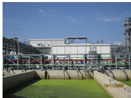
รูปที่ 3-21 บ่อพักน้ำทิ้งของโครงการ (Retention Pit)
