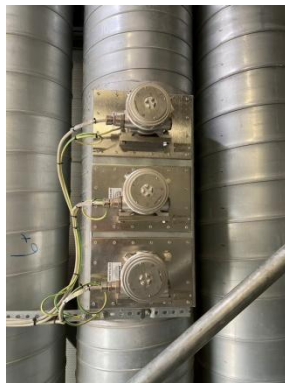
รูปที่ 3-46 ระบบตรวจจับก๊าซ (Gas Detector)
