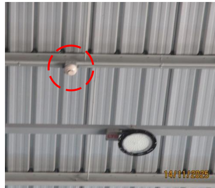
รูปที่ 3-45 อุปกรณ์ตรวจจับควัน (Smoke Detector)
