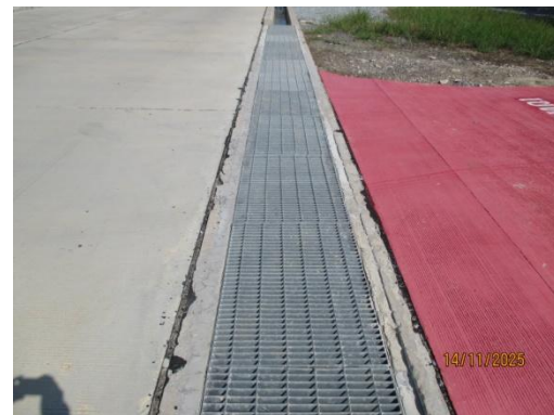
รูปที่ 3-24 รางระบายน้ำฝนปนเปื้อน
