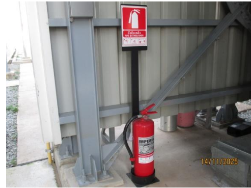
ถังดับเพลิงแบบมือถือ (Portable Fire Extinguishers)
